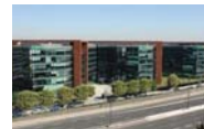
Le Hive, Hall de l'Innovation et Vitrine de l'Énergie Le Hive est le siège social de Schneider Electric. La rénovation de
